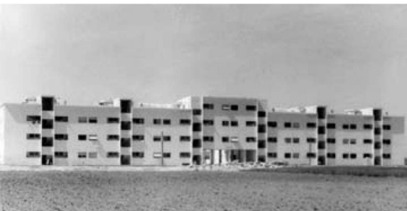
רח' דובנוב - חזית מזרחית, י. סגל DUVNOV ST. - EAST FACADE, J. SEGAL
