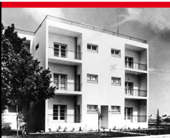
מעונות עובדים א' בקרית עבודה (חולון), י. נויפלד WORKERS' COOPERATIVE FLAT A, KIRYAT AVODA (HOLON), J. NEUFELD
